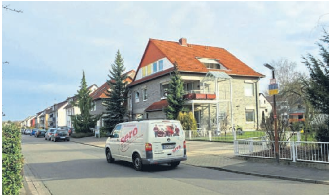
Die Zentrale der Sixti-Schwesternstation Northeim: Auf einer rückwärtigen Fläche (rechts im Bild) soll ein Anbau gebaut werden, in dem die Tagespflegeeinrichtung Einzug halten soll.
